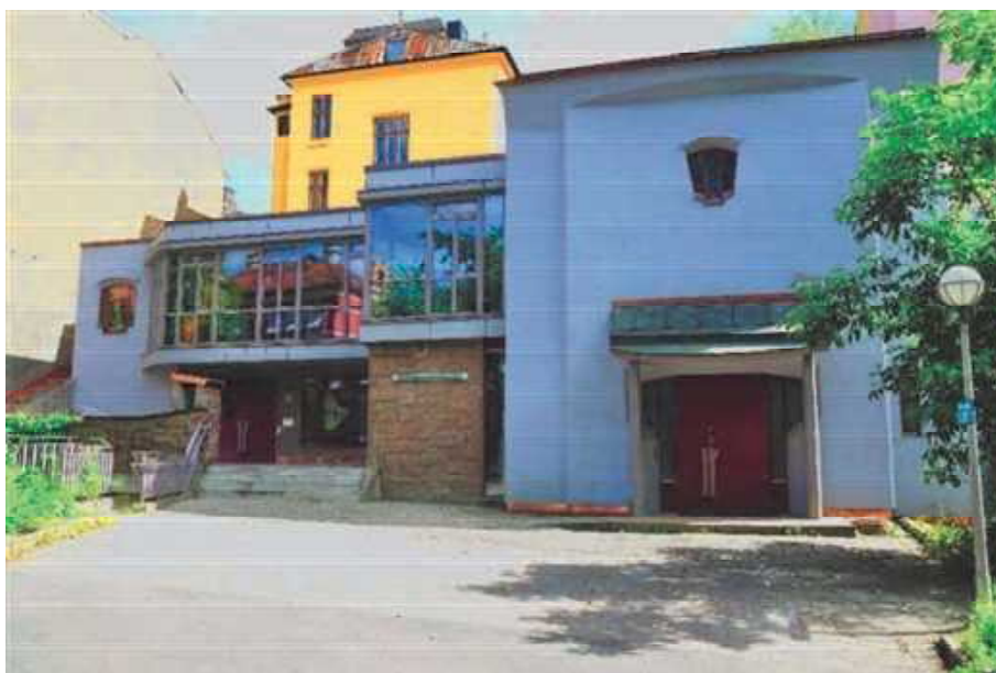
Mikaelkirken, fra Oscars gate, etter ombygging ca. 2016.
